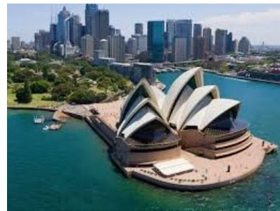
La toiture, si particulière de l'édifice, est composée de 1 056 006 tuiles de céramique blanche, autonettoyantes, qui donnent à l'ensemble de la structure un aspect parfaitement surnaturel.
